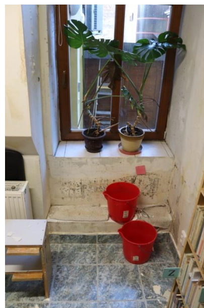
Obrázok 1 (Havária vodovodného potrubia)
